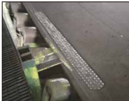
Side edge repair
